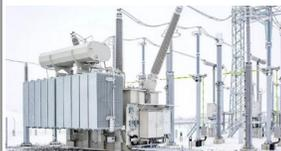
**Shunt reactors**, absorbent la puissance réactive et augmentent l'efficacité énergétique du système
