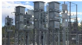
**Filtres harmoniques**, filtrent les harmoniques à des niveaux acceptables ; améliorent la stabilité de la tension et réduisent les pertes du réseau
